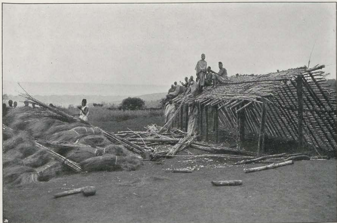
Fig. 78 und 79. Baracken im Bau.
