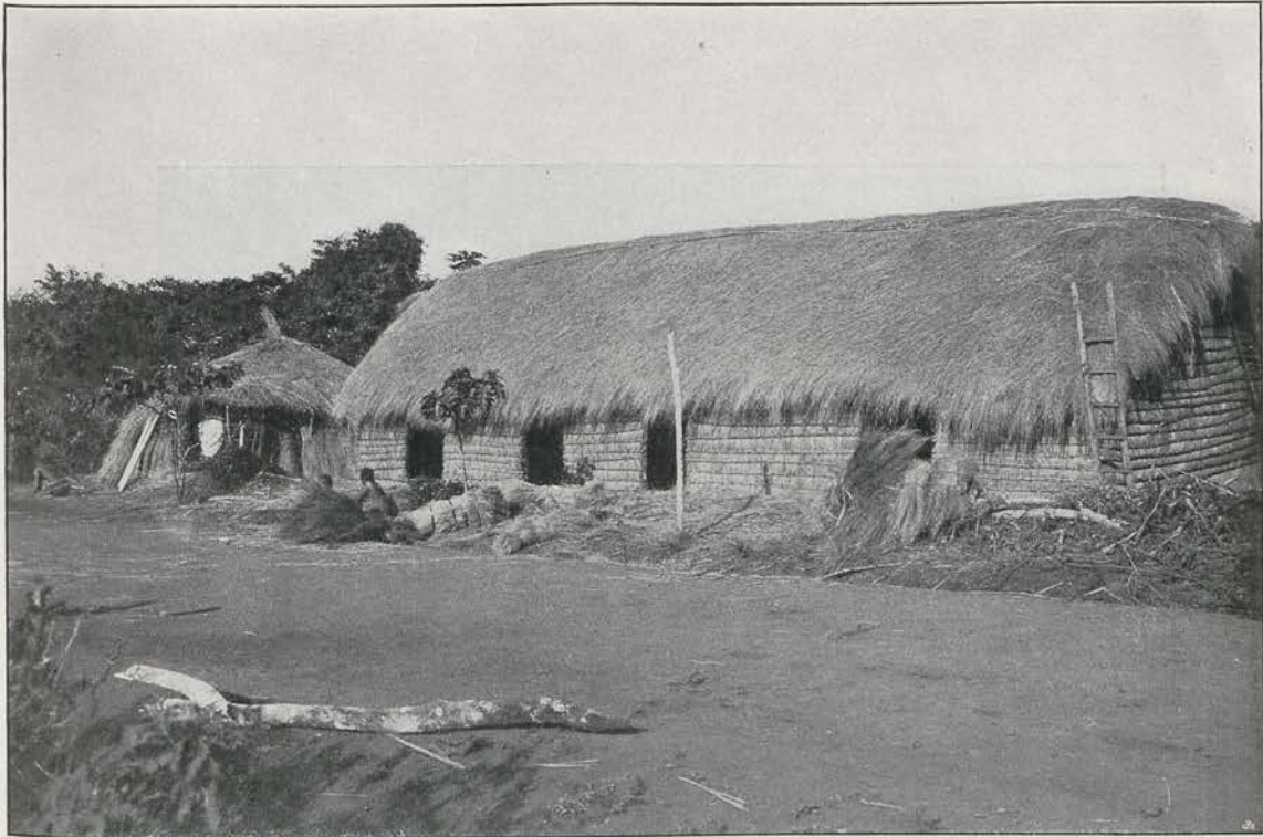
Fig. 80. Baracke im Bau.
